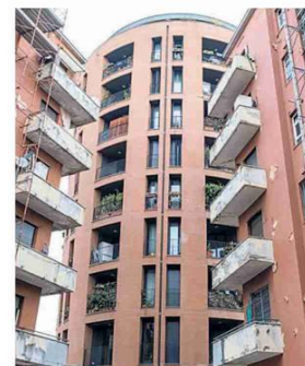
▲ I quartieri Lavori nelle case popolari di San Siro. FOTO ALBERICO / FOTOGRAMMA
