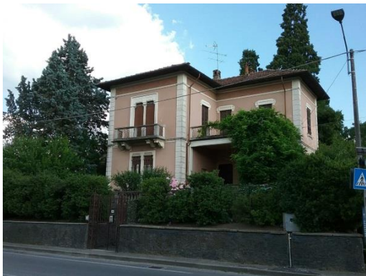
Vista frontale della villa
