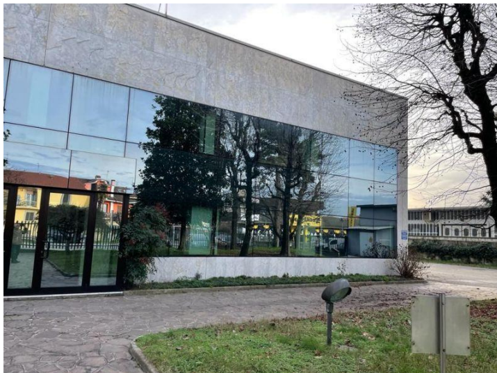
Vista del capannone
