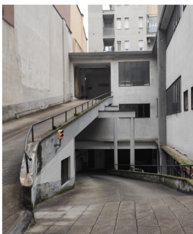
Vista delle rampe di collegamento interne tra i piani
