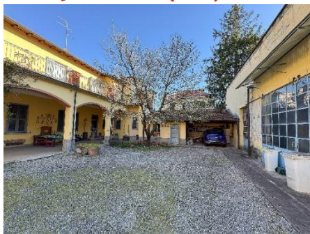
Vista interna dell'edificio storico
