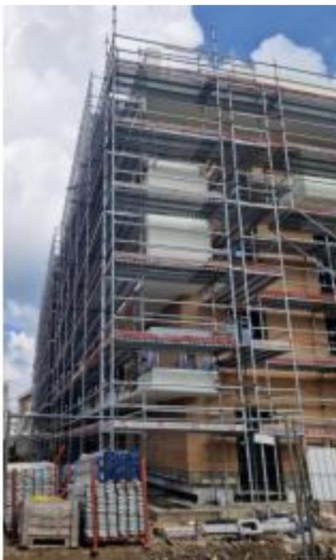
Il ponteggio multidirezionale è un prodotto di nuova concezione che presenta la stessa flessibilità di utilizzo del tubo/giunto a fronte di una più elevata velocità di montaggio e di un impatto estetico più pulito.
