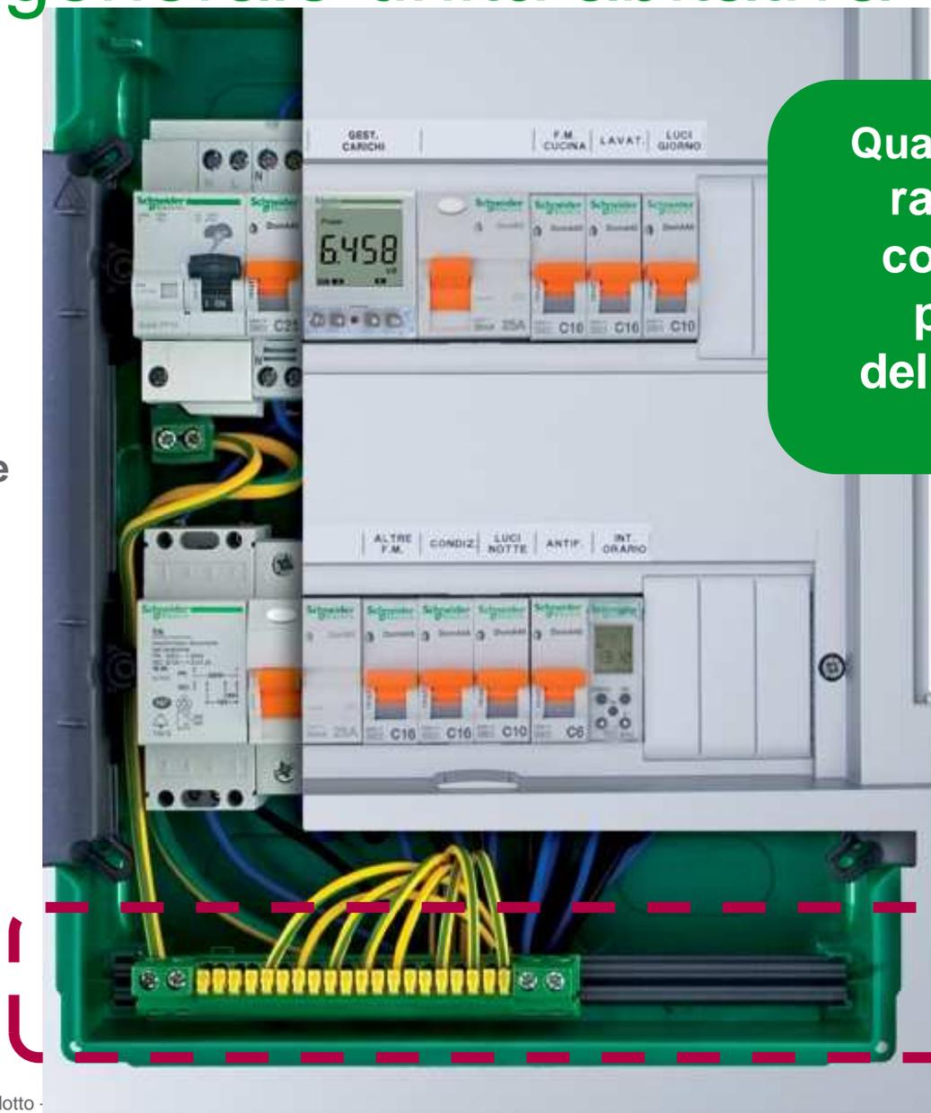
Quadro principale raggiunto da conduttore di protezione dell'impianto di terra
