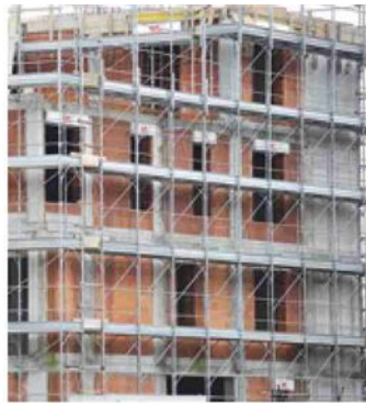
Un cantiere edile in città. L'allarme lanciato da Assimpredil riguarda il costo e la reperibilità delle materie prime, che rischiano di bloccare anche i cantieri legati al Pnrr oltre a tutto il settore privato dell'edilizia Archivio
