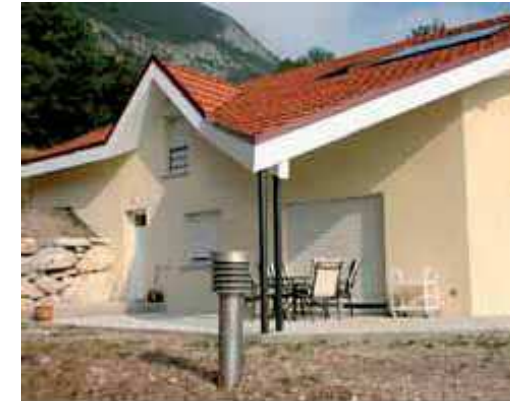
Abitazione nuova con "pozzo canadese"
