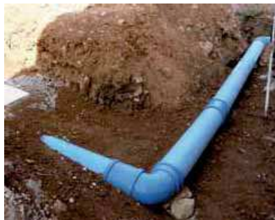
Posa del condotto geotermico
