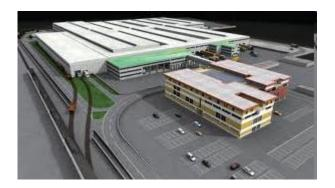
complesso organico di strutture e servizi integrati e finalizzati allo scambio di merci tra le diverse modalità di trasporto, comunque comprendente uno scalo ferroviario idoneo a formare o ricevere treni completi e in collegamento con porti, aeroporti e viabilità di grande comunicazione
