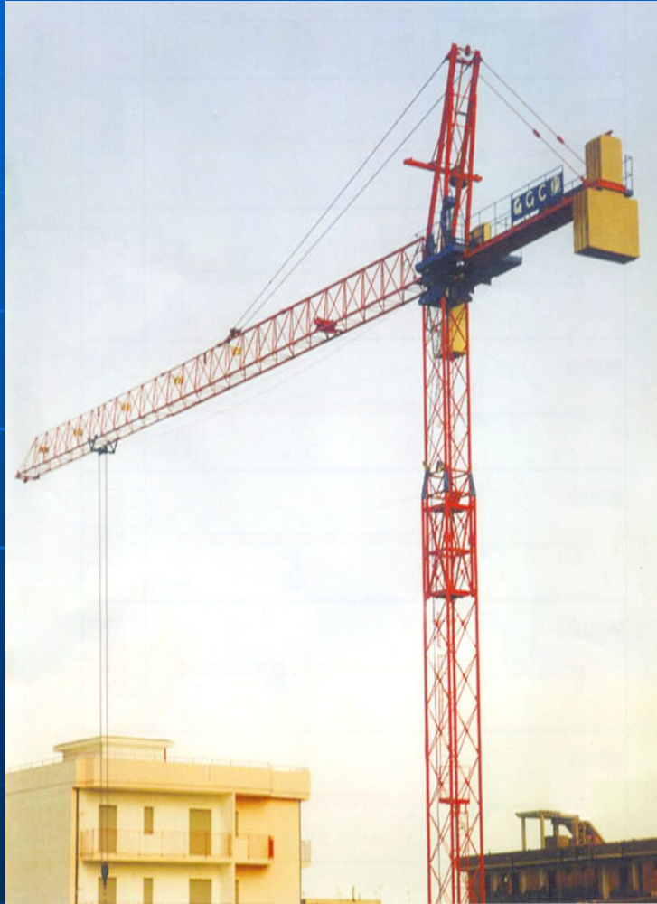
Gru a Torre con rotazione in alto
