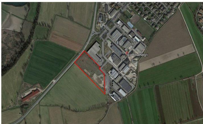
Veduta aerea dell'area
