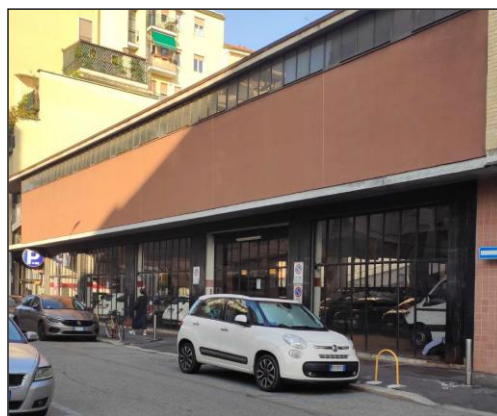
Vista del piano terreno su strada
