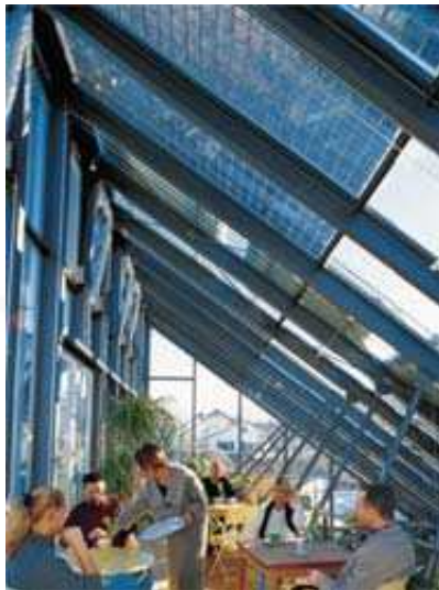
Sostituzione di elementi trasparenti
