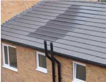
Tegola fotovoltaica (aspetto ardesiato)
