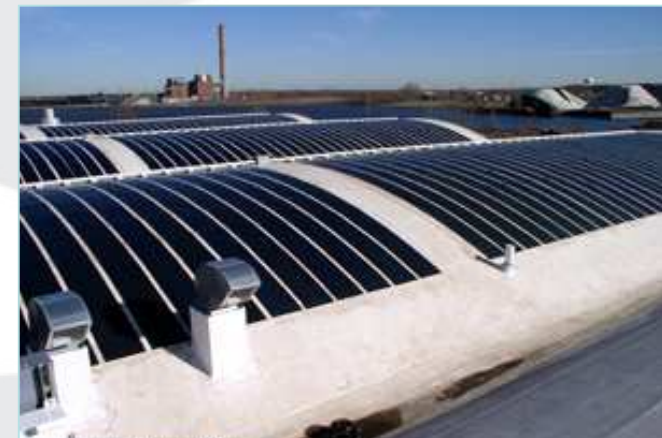
Sistema integrato impermeabilizzazione/fotovoltaico amorfo
